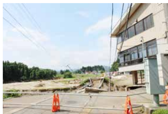
図7 崩落した大巻橋（飯豊町）
