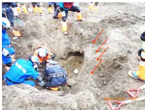
図2 掘削訓練時に生じた亀裂（その後崩落した）
