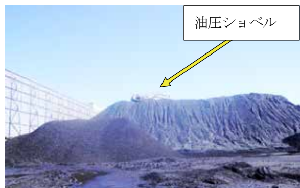
写真1：出火箇所周囲の状況
