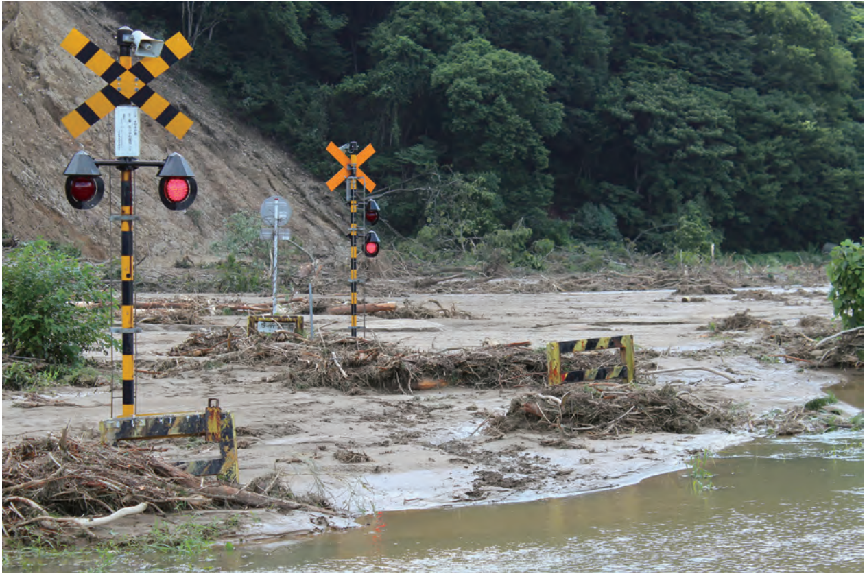
新潟県関川村 - 水没した越後大島駅の踏切（2022年8月撮影）
