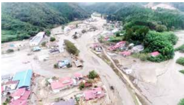
写真-6 2019年東日本台風による宮城県丸森町五福谷川で発生した土砂・洪水氾濫 (国土交通省宮城南部復興事務所提供)
