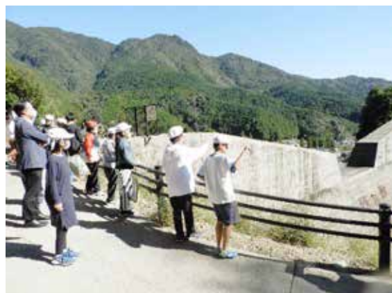
図10 砂防堰堤の見学
