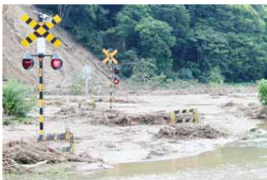
図3 水没した越後大島駅西側の踏切
