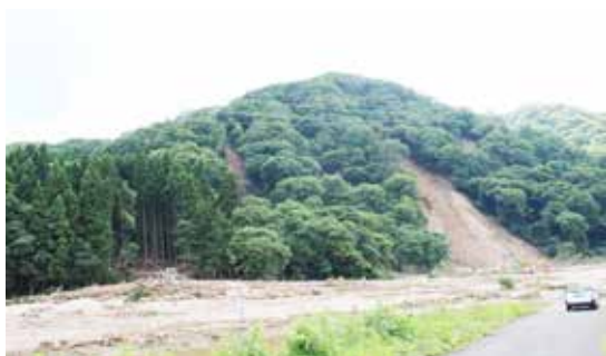
図2 関川村での斜面崩壊
