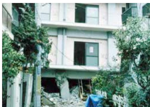
写真2 1階ピロティ柱が破壊した4階建て RC造集合住宅（阪神・淡路大震災）
