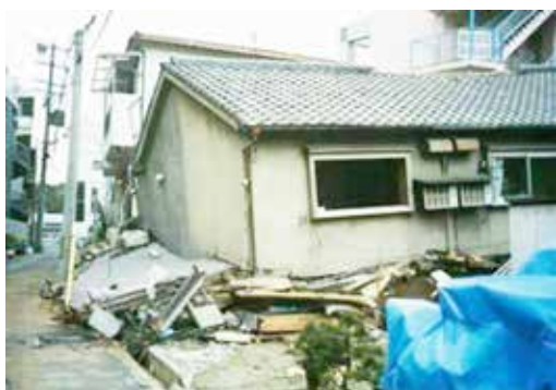
写真1 1階が倒壊した古い木造住宅 （1995年阪神・淡路大震災）
