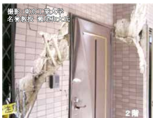
写真5 損傷した集合住宅の間仕切り壁とドア（2005年福岡県西方沖地震）
