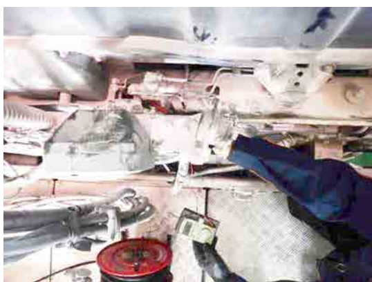
写真7 漏電立証時の状況（漏電点）
