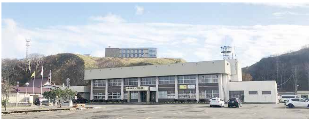
図2. 釧路管内浜中町の津波浸水区域内にあった旧役場と高台移転した新役場庁舎（浜中町役場提供）
