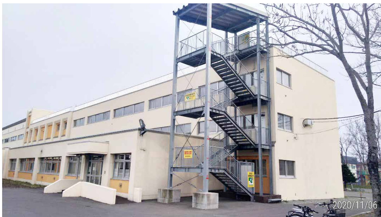
図3. 釧路市内の津波浸水想定区域内の小学校に設置された屋外避難階段
