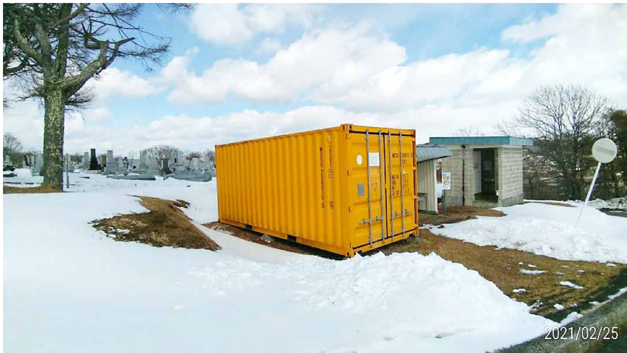
図4. 釧路管内白糠町の屋外津波緊急避難場所に設置された備蓄倉庫。 内部には薪ストーブなどの採暖用品も備蓄されている
