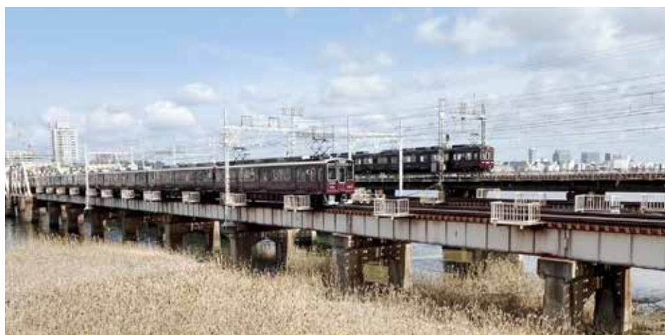
写真2 淀川に架かる鉄道橋（手前の阪急電鉄神戸線、宝塚線鉄橋は100年確率洪水対応、背景の京都線鉄橋は200年確率洪水対応で、前者より約1.5m 高くなっている。）（筆者撮影）
