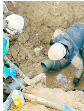
(2) 掘削工事状況 2)
