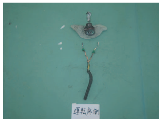
写真19 配線及び接続部
