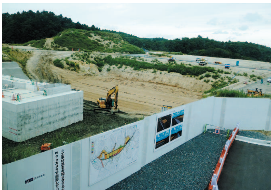
新野蒜駅から見た復興工事の状況 （2015年9月17日撮影）
