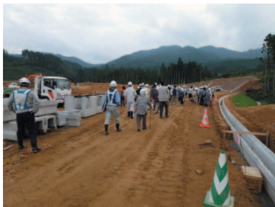
写真1 造成工事現場見学会の様子(2014年9月5日)
