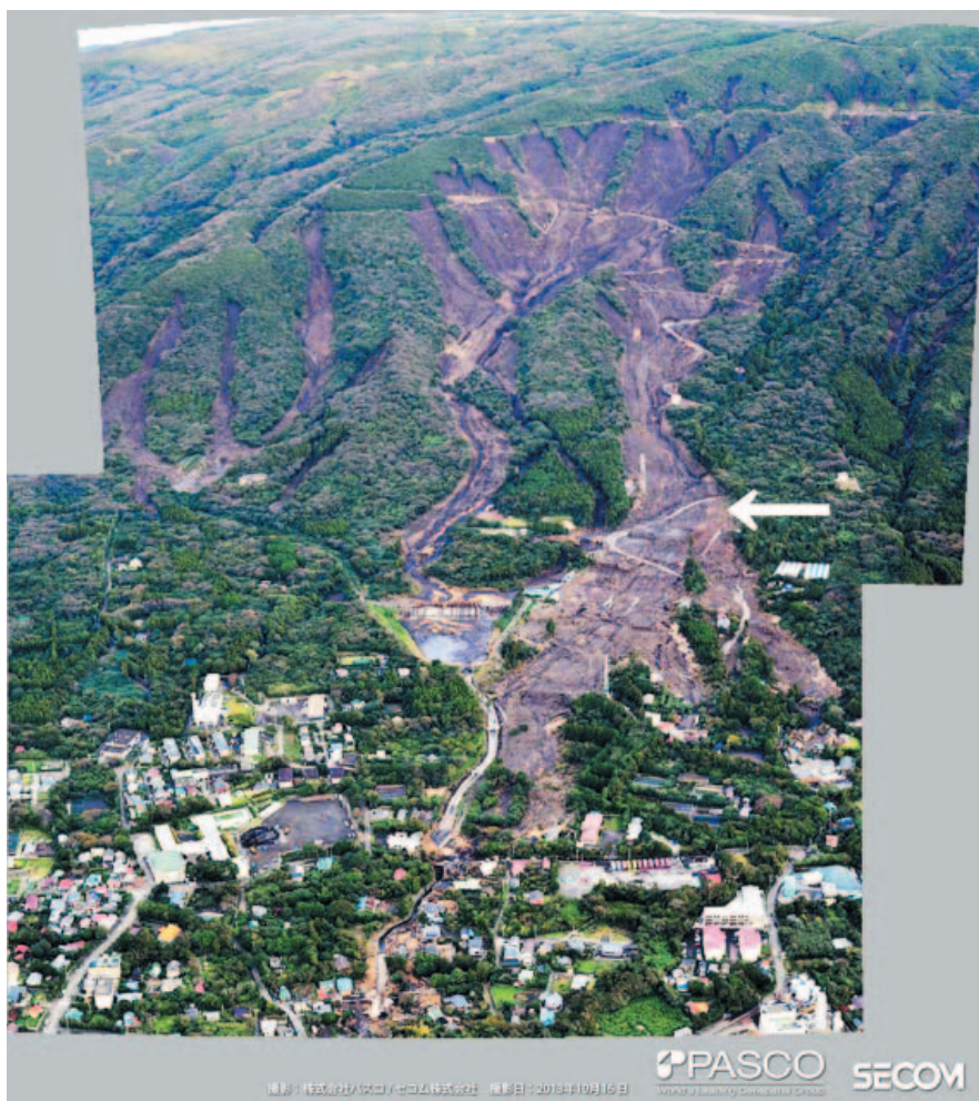
図3 10月16日に撮影された空撮画像（（写真提供：株式会社パスコ）
