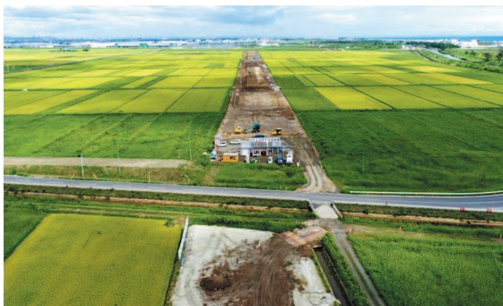
↑ 『整備工事中的のかさ上げ道路（9/2 現在）』
