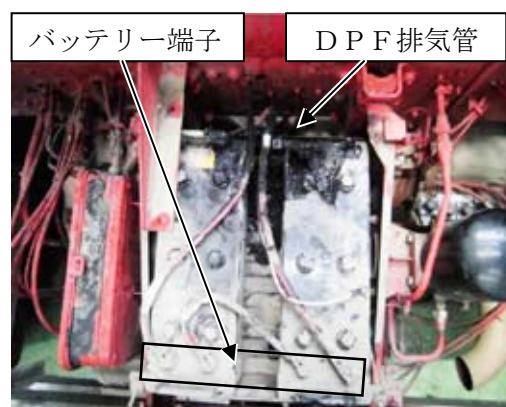
写真5 バッテリー及びバッテリー線
