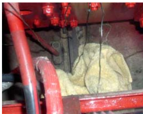
写真9 綿タオルの設置状況
