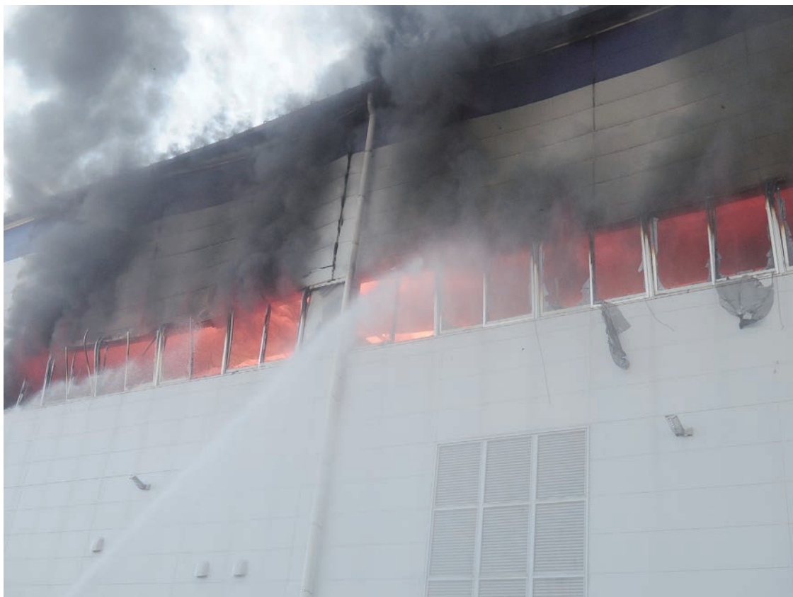
2 階北側の燃焼状態（2017年 2 月16日撮影）
