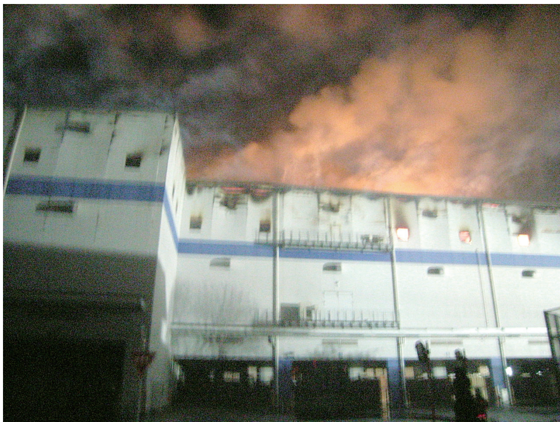
西面延焼状況（2017年 2 月19日撮影）
