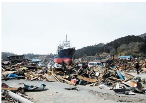
写真-3 複合災害（気仙沼市鹿折地区）
