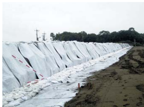
図8 土のうによる仮締切の状況
