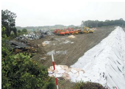
図8 土のうによる仮締切の状況
