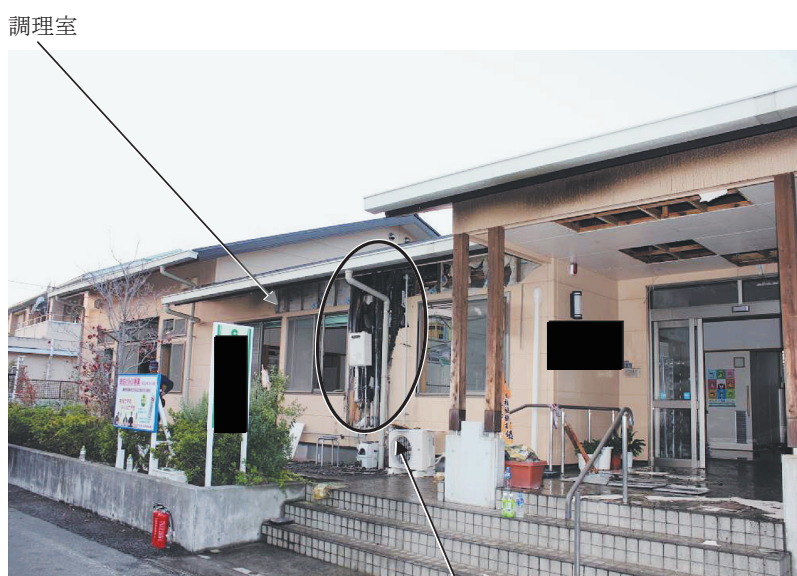
建物壁面の上方へ扇状に広がる焼損箇所（外壁）
