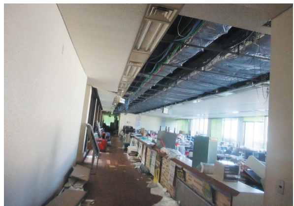
崩落した庁舎1階天井
