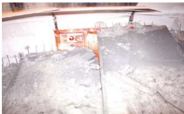
落下した天井板が覆いかぶさった消火栓の状況
