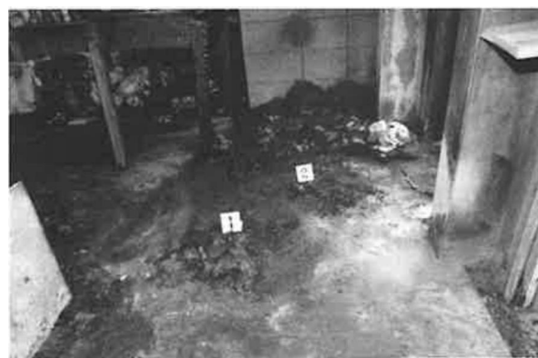
出火箇所付近の状況
