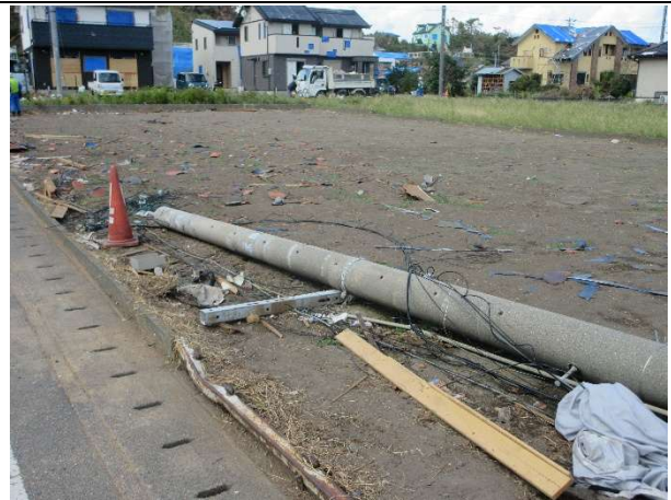
倒壊した電信柱 周辺に散乱していた
