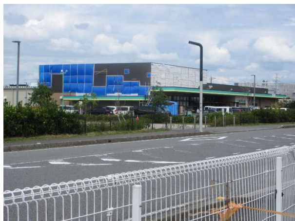
外壁が破損した店舗
