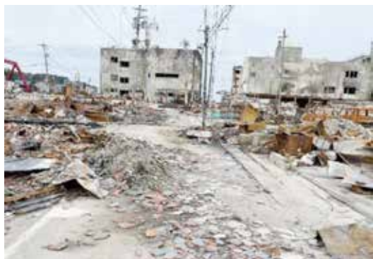
図3 路上での延焼跡
