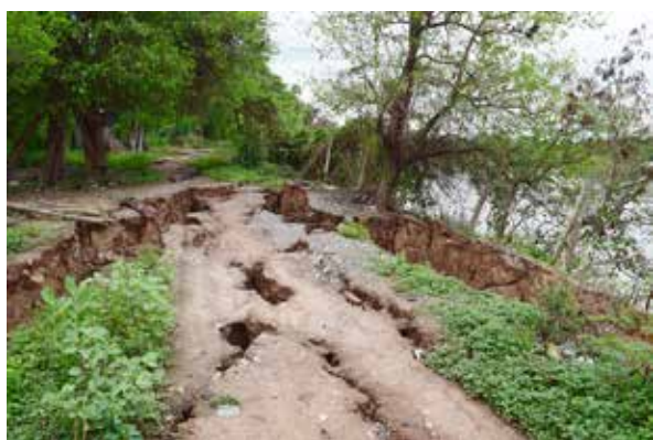
写真8 河岸の亀裂
