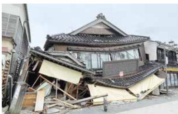
図6 1階が座屈した建物
