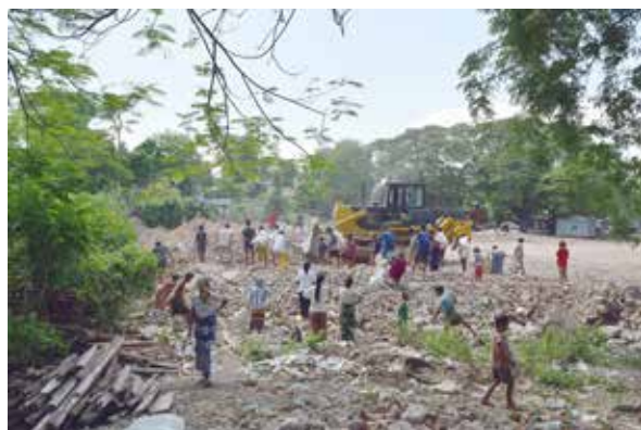
写真5 瓦礫の撤去作業
