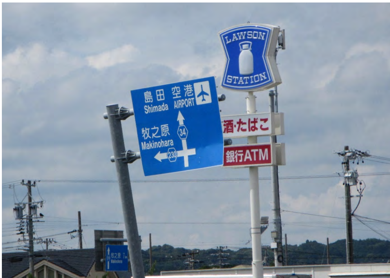
竜巻により折れ曲がった表示板と柱（静岡県吉田町神戸付近、令和7年9月撮影）
