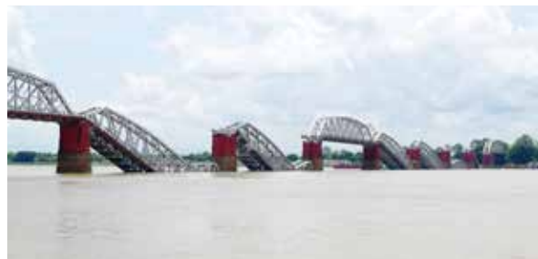
写真11 倒壊したアヴァ橋
