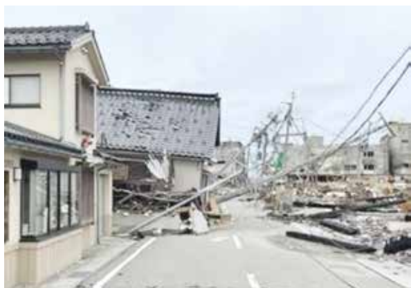
図4 倒壊建物の道路側への倒れ込み（輪島警察署あさいち交番付近）
