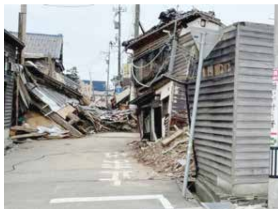
図2 「馬だし小路」の倒壊家屋による閉塞と一部が焼け残った裸木造建物の外壁の剥離
